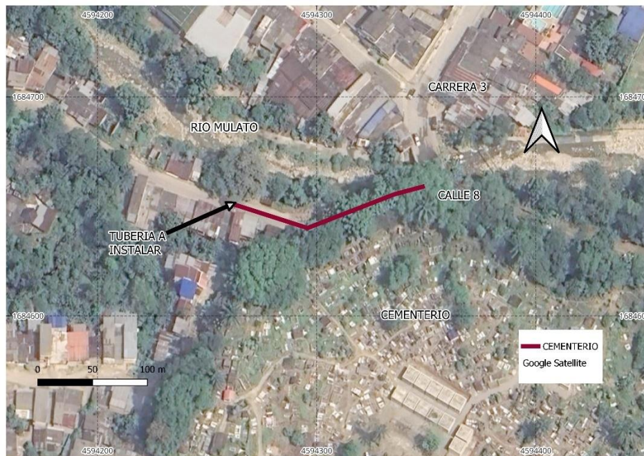
Figura 16. Localización de las obras de alcantarillado faltantes en el sector del cementerio
